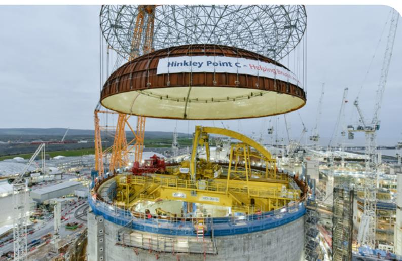
Setzen der Containmentliner-Kuppel HPC Block 1
