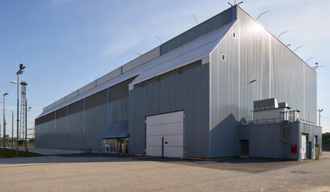
Standortzwischenlager Isar. Foto: BGZ
