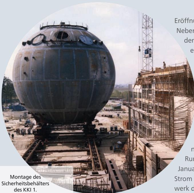
Montage des Sicherheitsbehälters des KKI 1.
